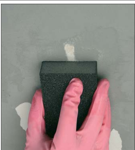
Rester af tapet fjernes med en slibesvamp fugtet med tapetopløser.
