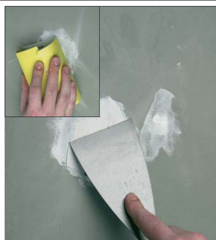
Huller udspartles med polyfilla udrørt i vand. Når spartelmassen er tør, slibes med sandpapir korn 120 sat på en slibeklods eller et slibebræt.
