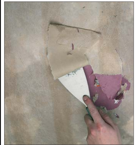
Det oplødte tapet fjernes med en spartel.
