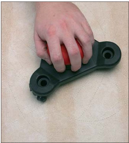
Tapetet perforeres med en tapetridser.
